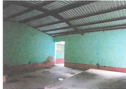
Foto 4: Pintura y repello en mal estado.
